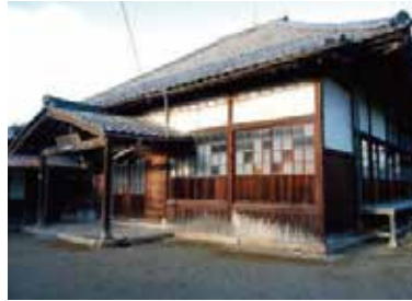
現在は移築された弘道館（現金亀会館）の様子
