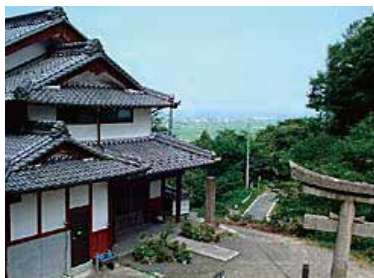
平成3(1991)年に火災により焼失した望湖堂
